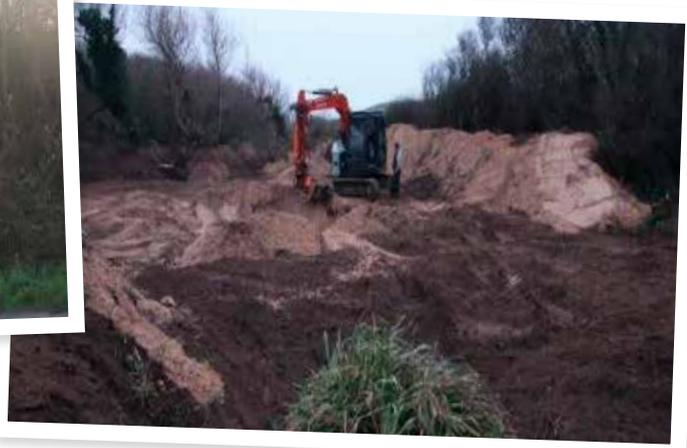
Les travaux réalisés ont consisté en la suppression d'une partie du boisement artificiel par abattage et broyage, puis à du terrassement pour recréer une dépression humide inondée temporairement avec un point bas sous forme de mare. Un suivi écologique sera mis en place au printemps 2023 par le garde gestionnaire du site.
